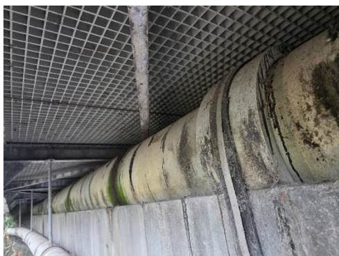
Abb. 7: Werkleitungen unter dem seitlichen Gehweg
