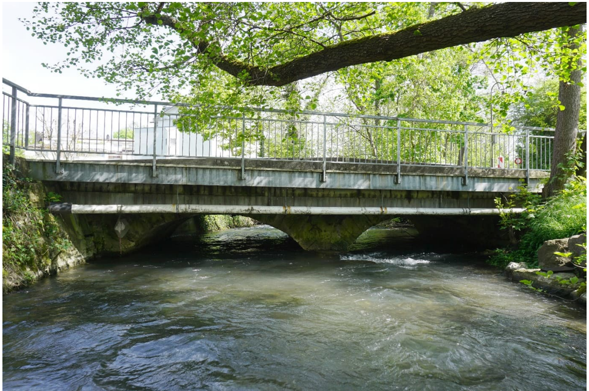
Abb 05: Seitenansicht in Fliessrichtung (Norden)
