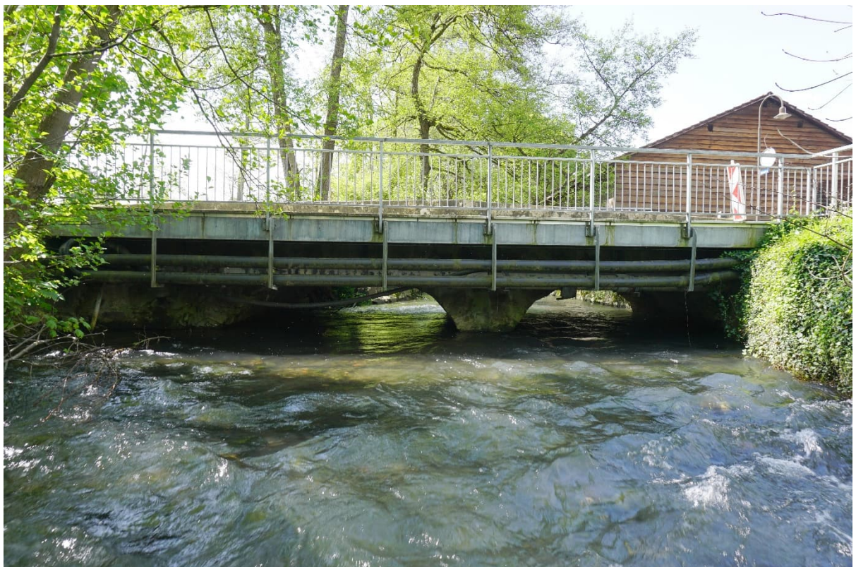
Abb. 06: Seitenansicht gegen Fliessrichtung (Süden)
