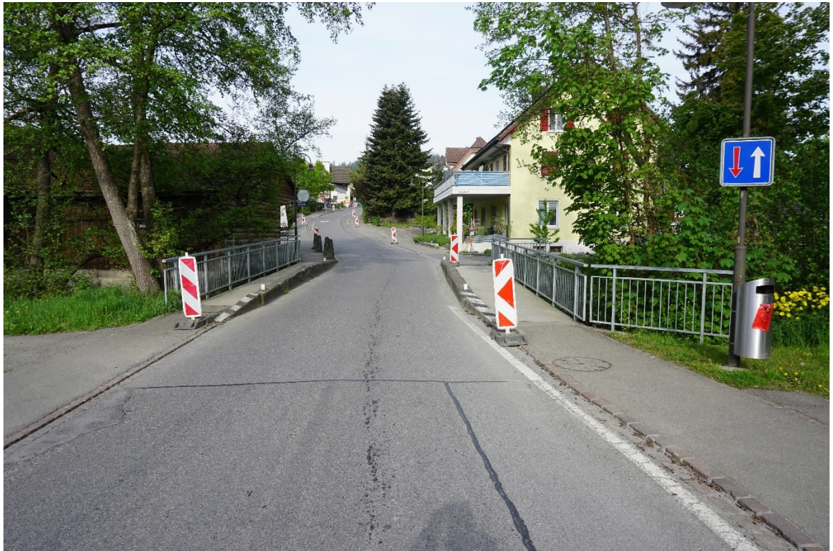
Abb. 03: Draufsicht Richtung Westen (Hauptstrasse / Seon Zentrum)
