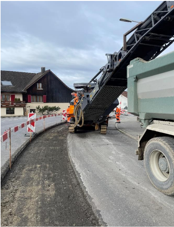
Abb. 4: Belagsfräsarbeiten Bauetappe 5
